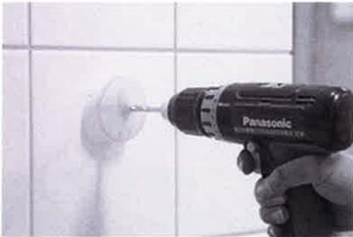
[ Bild 1.] Märk ut önskat läge på detaljen (lämpligast mitt i kakelplattan) förborra genom väggens alla material med 5.5mm borrar typ Wedevåg hårdmetall.
