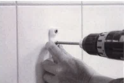
[ Bild 5.] Detaljen monteras med lämplig skruv, rostfri eller mässing Ø 3.5 - 5mm.
