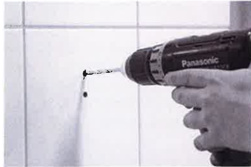
[ Bild 2.] 7 mm borrar endast genom kakel (använd kakelborr) Våtrumssilikon i hålet.
